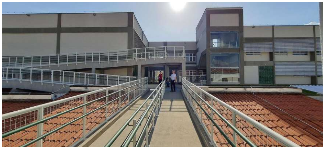
Rampa de acesso à Clínica Escola e ao seu 1º andar
