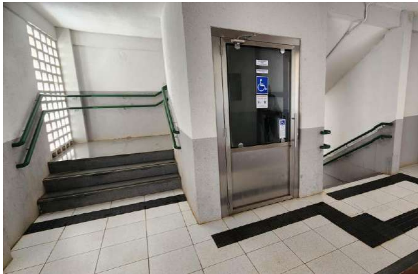
Plataforma acessível para acesso ao 1º andar
