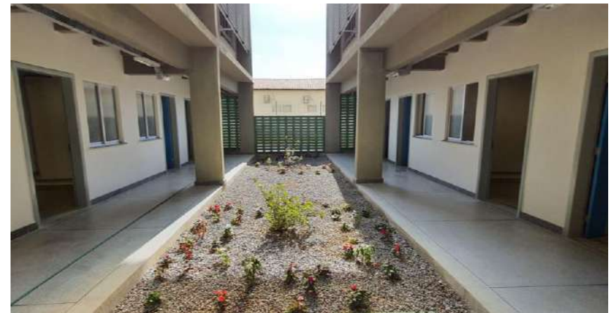
Entrada dos ambulatórios
