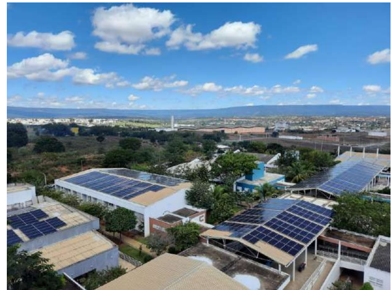
Placas solares para geração de energia
