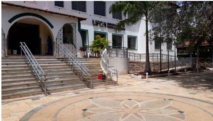
Rampa e escada de acesso principal
