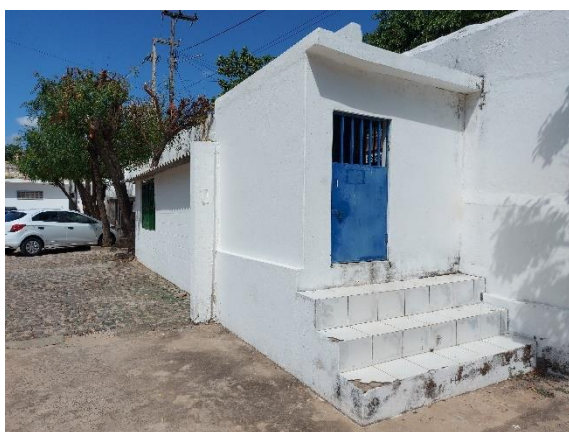
Figura 6. Abrigo externo para resíduos dos grupos A e E
