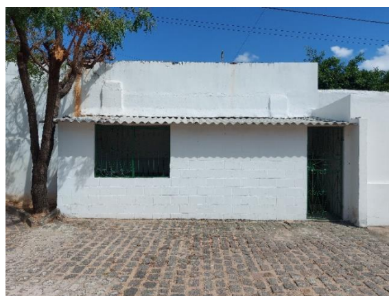
Figura 7. Abrigo externo para materiais recicláveis
