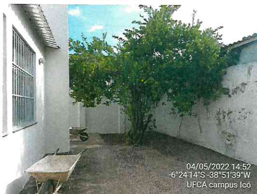
Figura 6. Área externa com a disposição de brita no solo
