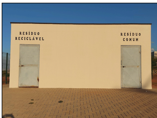
Figura 11 - Abrigo de resíduos recicláveis e comum no campus Juazeiro do Norte
