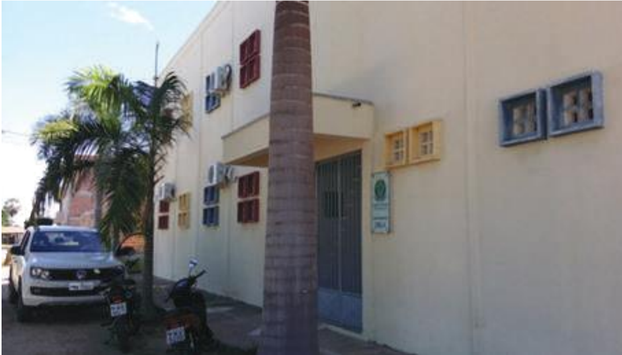
Figura 18 – Campus Icó – Foto da Fachada
