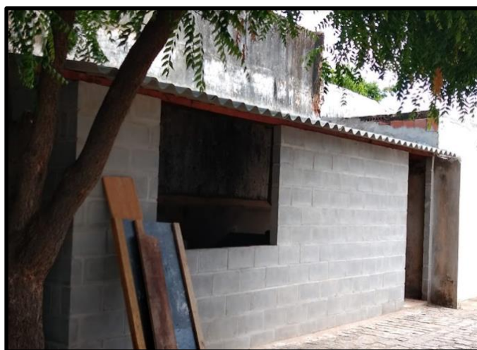
Figura 1: Abrigo externo do campus Barbalha para triagem e armazenamento da coleta seletiva
