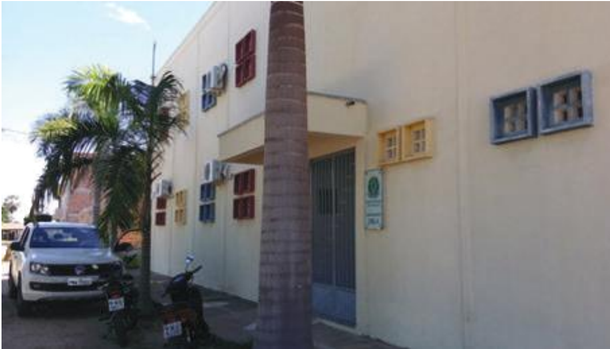
Figura 18 – Campus Icó – Foto da Fachada
