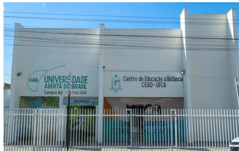
Figura 5: Instalações físicas do CEAD no município de Icó-CE
