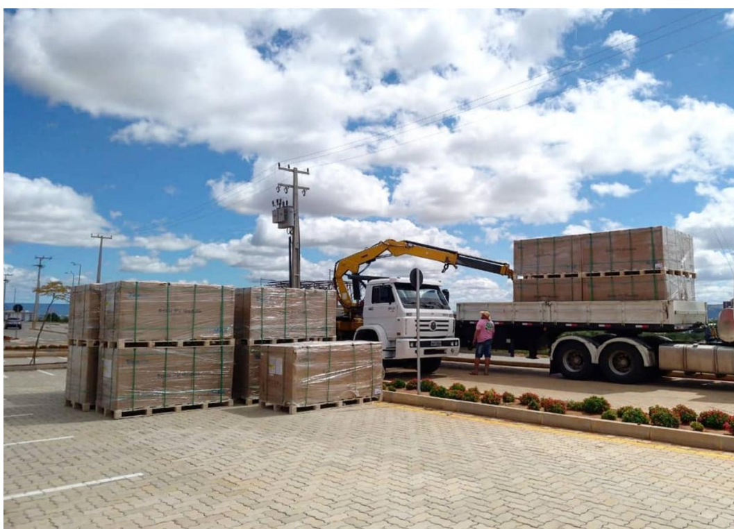
Figura 2 – Painéis solares chegando no campus Juazeiro em julho/2020
