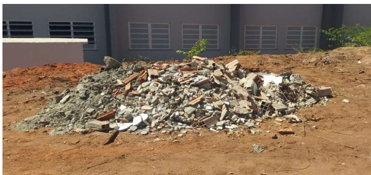
Figura 21 - Segregação dos resíduos classe A em pilhas, após a capacitação
