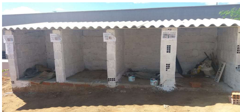
Figura 25 - Acondicionamento dos RCCs no canteiro de obras da empresa B após a capacitação.
