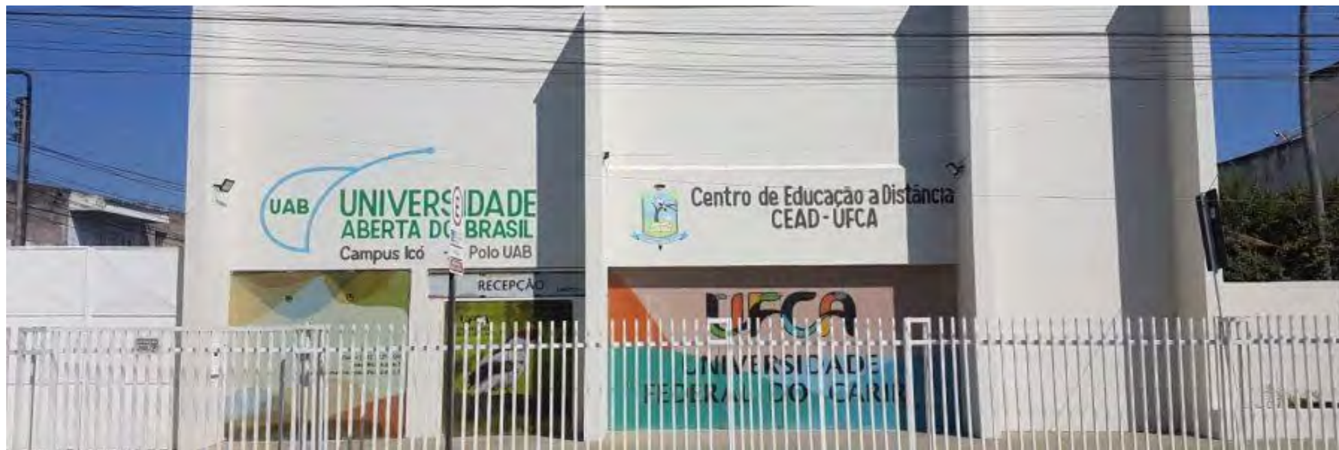
Figura 1: Instalações físicas do CEAD—Campus do Município de Icó-Ce
