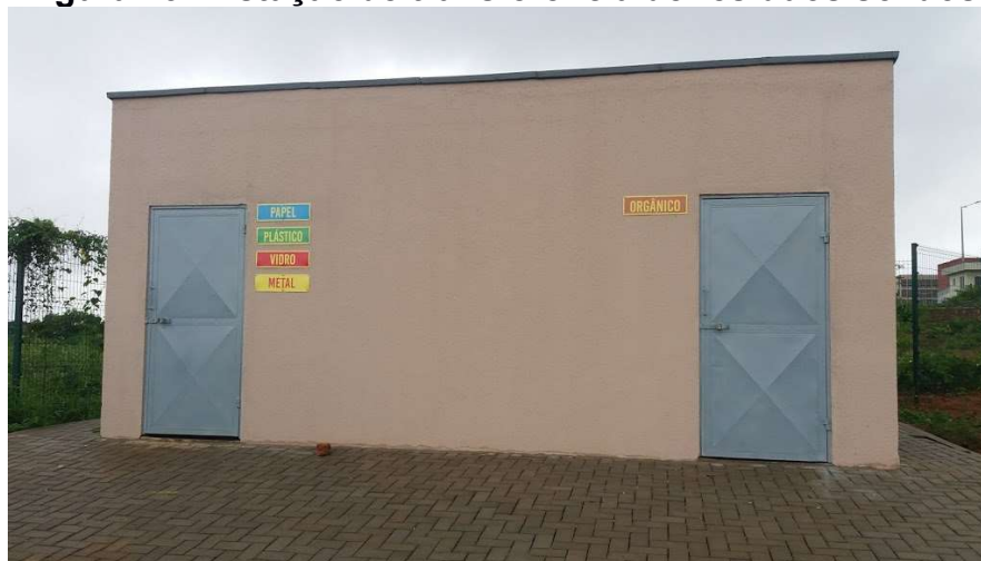
Figura 13 - Estação de transferência de resíduos sólidos
