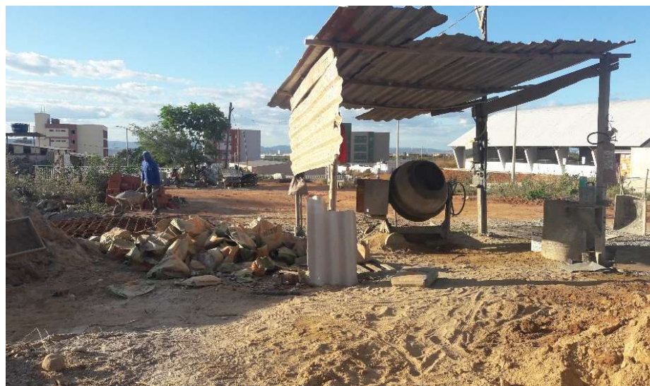
Figura 20 - Central de concreto.
