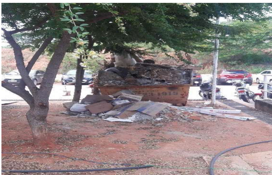
Figura 24 - Acondicionamento dos RCCs no canteiro de obras da empresa B antes da capacitação.
