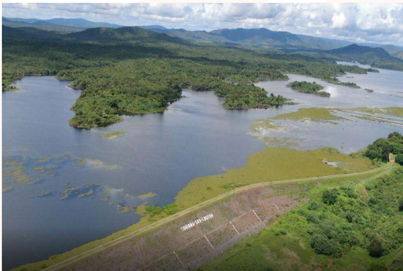
Figura 2.3 - Vista aérea do Açude Rosário
