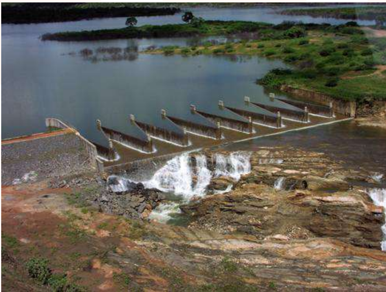
Figura 2.4 - Vista aérea do vertedouro Creager em concreto do Açude do Rosário.
