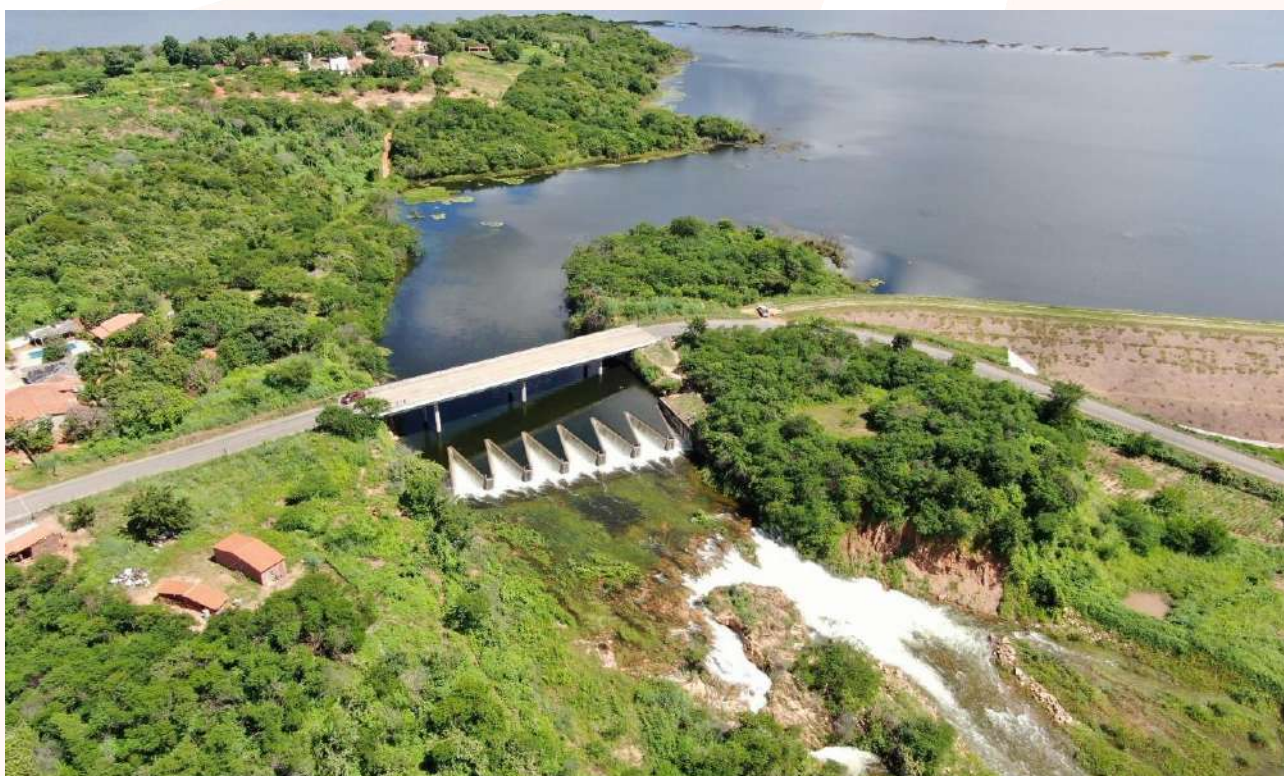
Açude Ubaldinho – Foto: Cogehr
