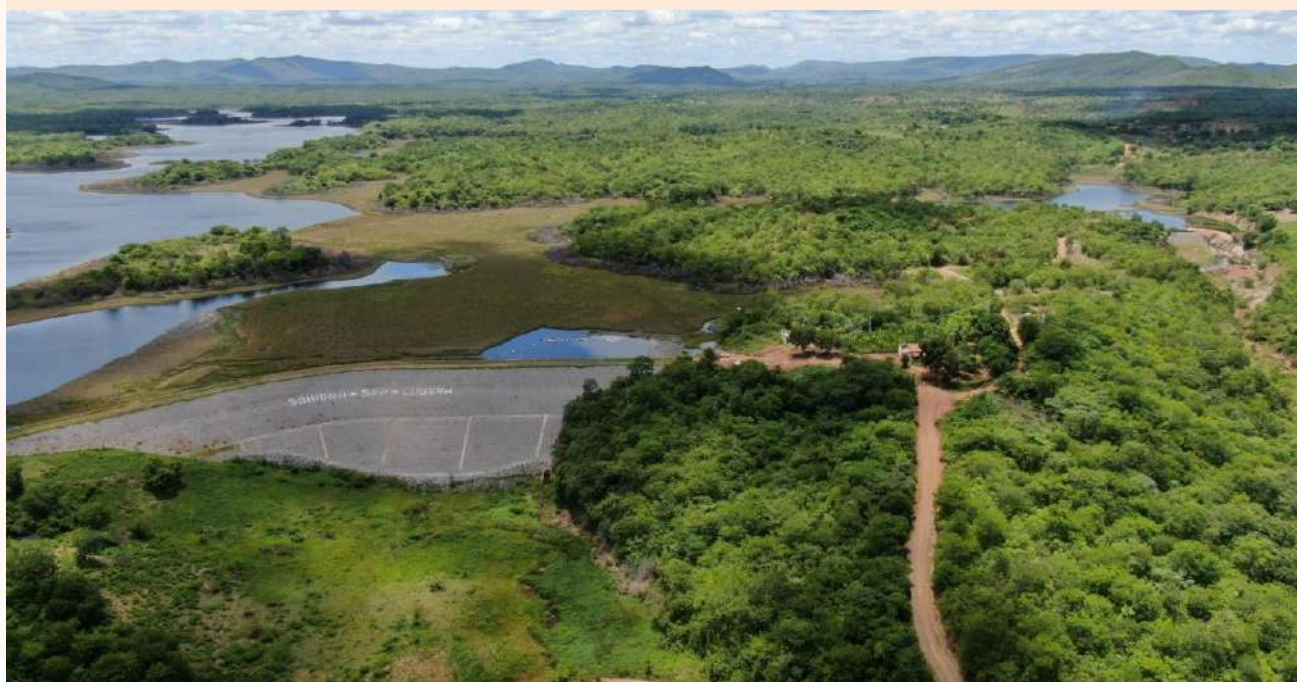
Açude Cachoeira – Foto: Cogeh
