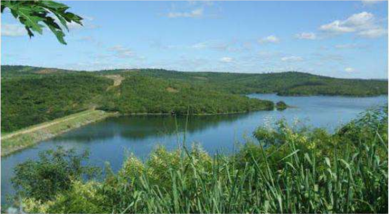
Foto: Vista de montante para o reservatório (Fonte: Google Earth)
