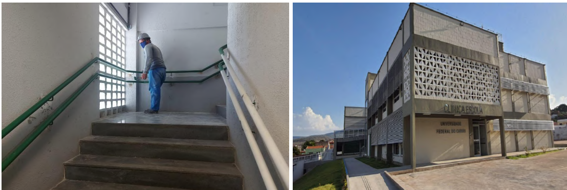
Figura 13 - Obras de combate a incêndio e acessibilidade e construção da Clínica Escola, Campus Barbalha
